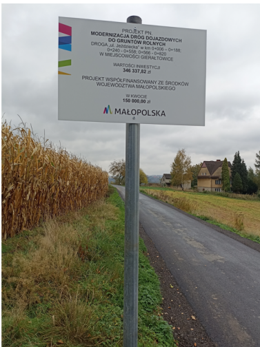
Droga - ul. Jeździecka w Gierąttowicach
